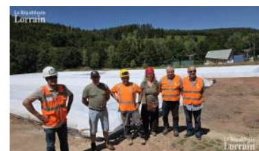
La réunion de chantier réunissant les responsables de la communauté des communes, de Suez, de la mairie et de l'entreprise Lingenheld a permis de faire le point sur la deuxième phase du projet. Photo Bernard Eschenbrenner
