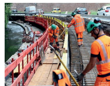
Chantier de réhabilitation du mur de soutènement le long de la RD132, entre Lutzelbourg et Stammbach, le 3 juin 2026. Photo Laurent Rea
