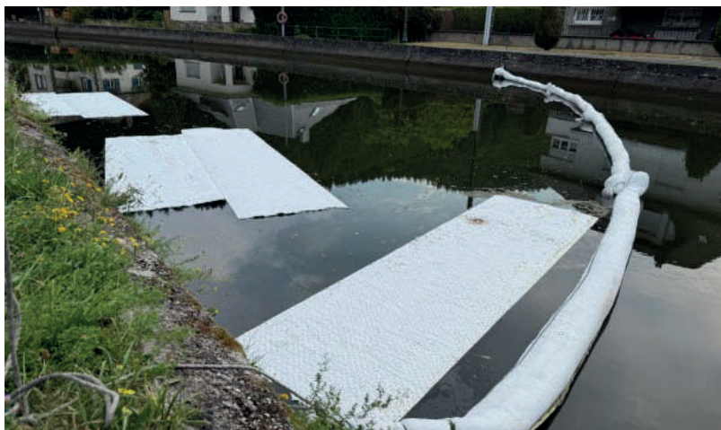
Un barrage flottant et des buvards ont été installés pour la nuit, permettant l'absorption en grande quantité de gasoil se trouvant sur la surface de l'eau. Photo Lucas Rodriguez
