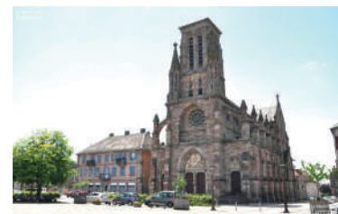
Des infiltrations menacent le grand orgue et la présence d'oiseaux pose problème depuis plusieurs années. Photo Sylvain Lorch
