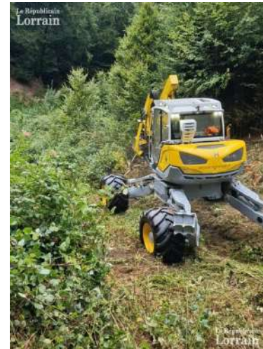
La pelle araignée débroussaille le tracé de la conduite d'eau au Kleinthal. Photo Christophe Spengler
