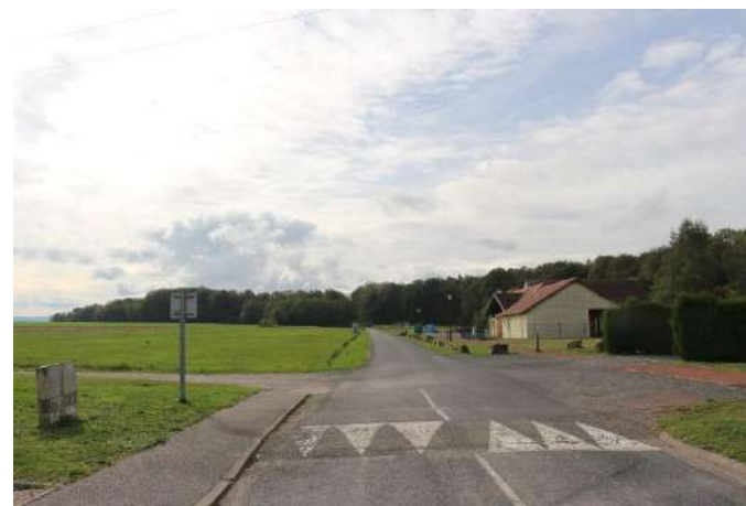
Vue de la salle polyvalente en sortie de la rue d'Arzwiller
