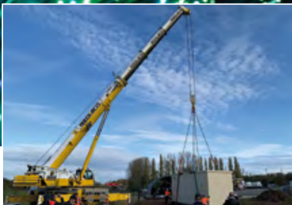
Pose du NRO (Nœud de Raccordement Optique) de la plaque de Phalsbourg. Equipement d'une trentaine de tonnes.
