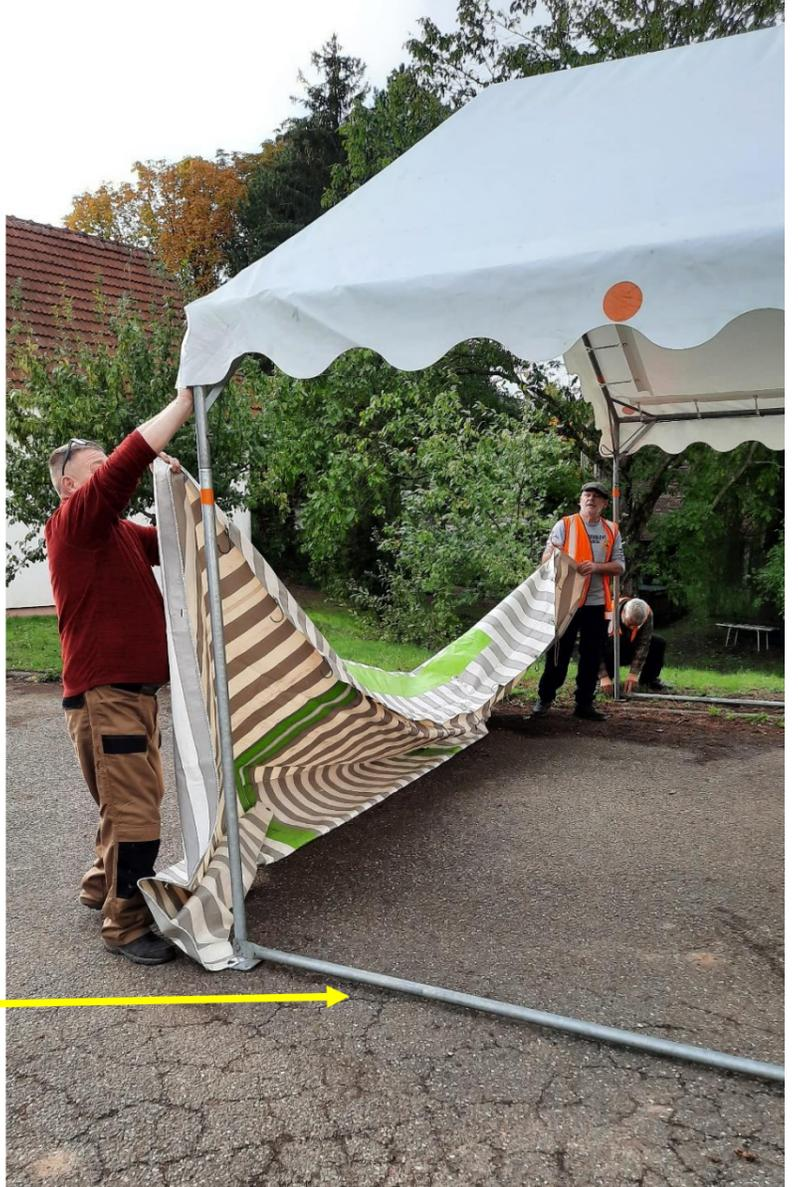
Fixation des barres latérales au sol et des bâches des côtés + façade (Porte)
