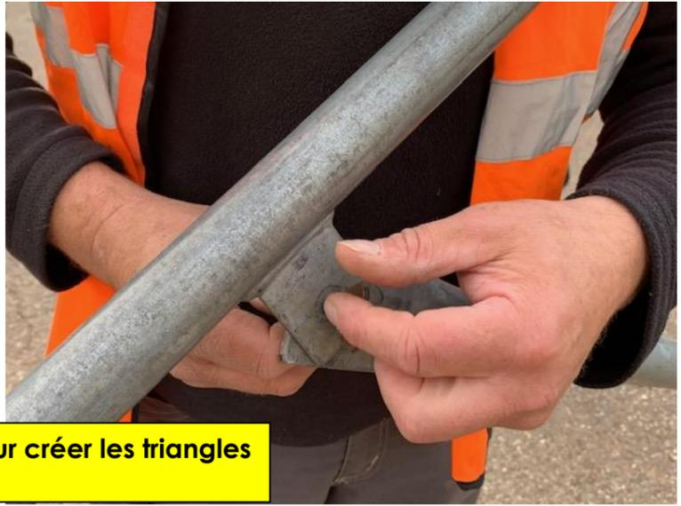
Fixation des 3 entrants du toit pour créer les triangles
