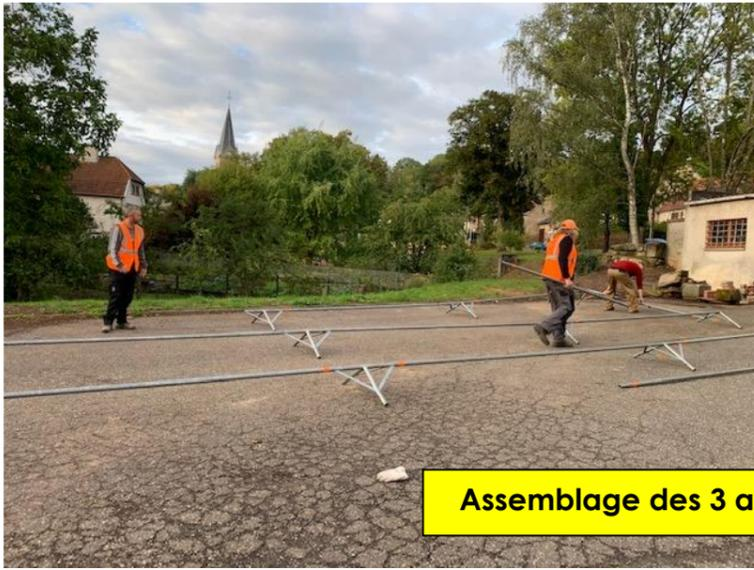
Assemblage des 3 axes principaux de la toiture
