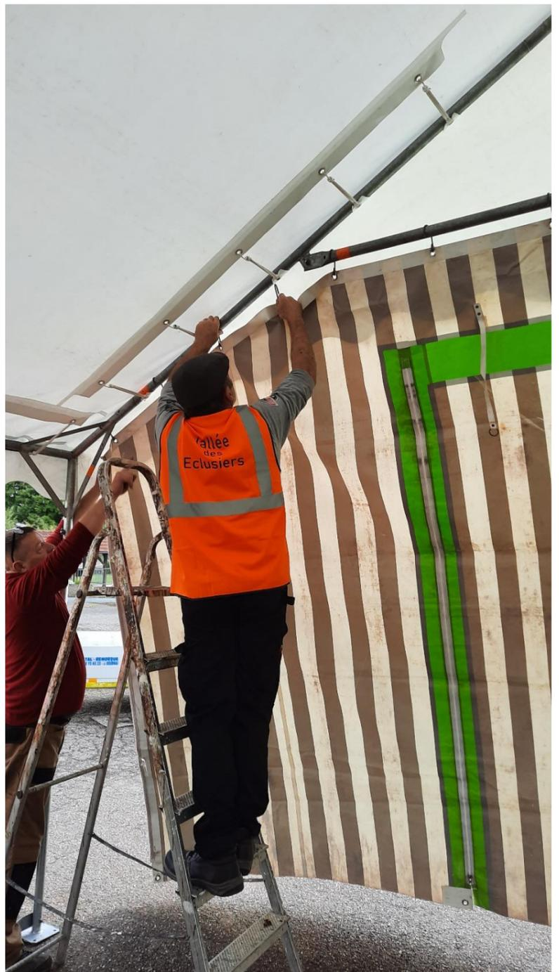
**Haubanage de la structure et implantation des piquets**
