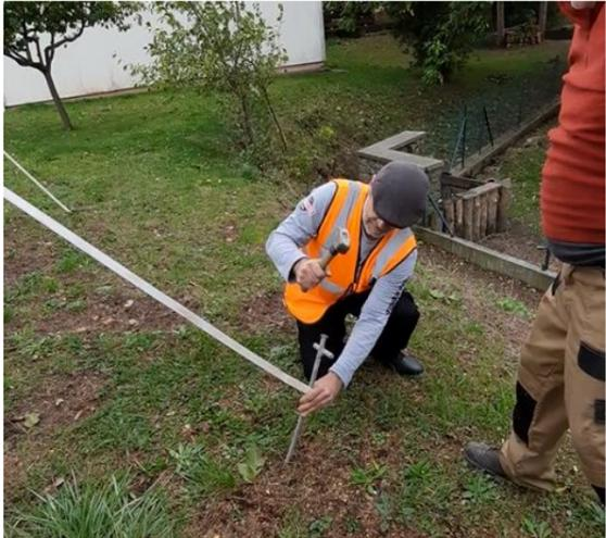
**Fixation des sangles sur les barres pour arrimer la structure au sol à l'aide des piquets**
