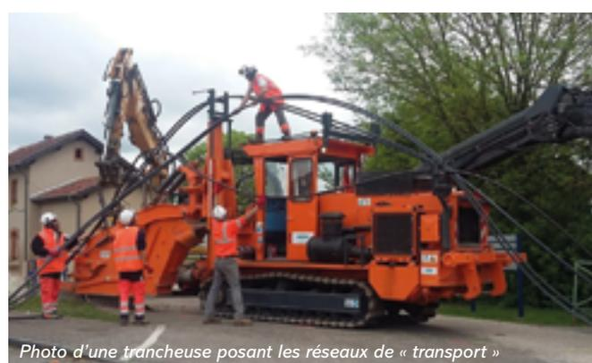
Photo d'une trancheuse posant les réseaux de « transport »
